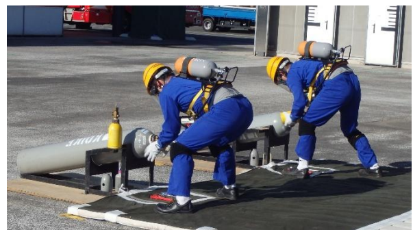
塩 素 容 器 へ の 防 災 キ ャ ッ プ の 取 付 け
